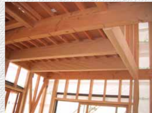
リビングの施工途中の様子。完成後はむきだしにして、見せる梁とするため、工事段階から養生をしている。
