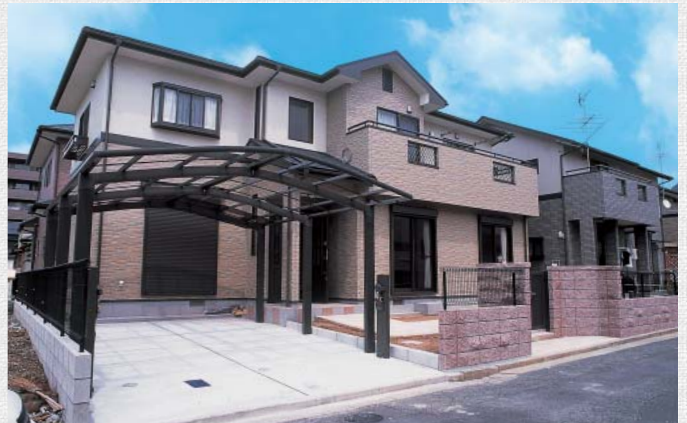
お施主様の要望にあわせて車2台分のカーポートを設置
