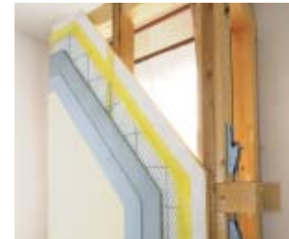
モデルハウス内に設置された「HAWシステム」壁体構造の現物
