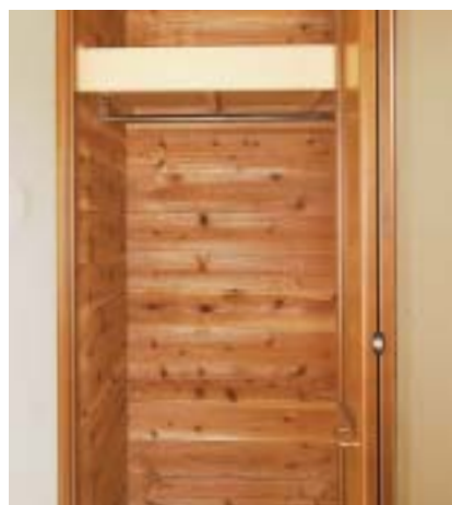
押入れの中の材料は、宮城の杉の間伐材を使用
