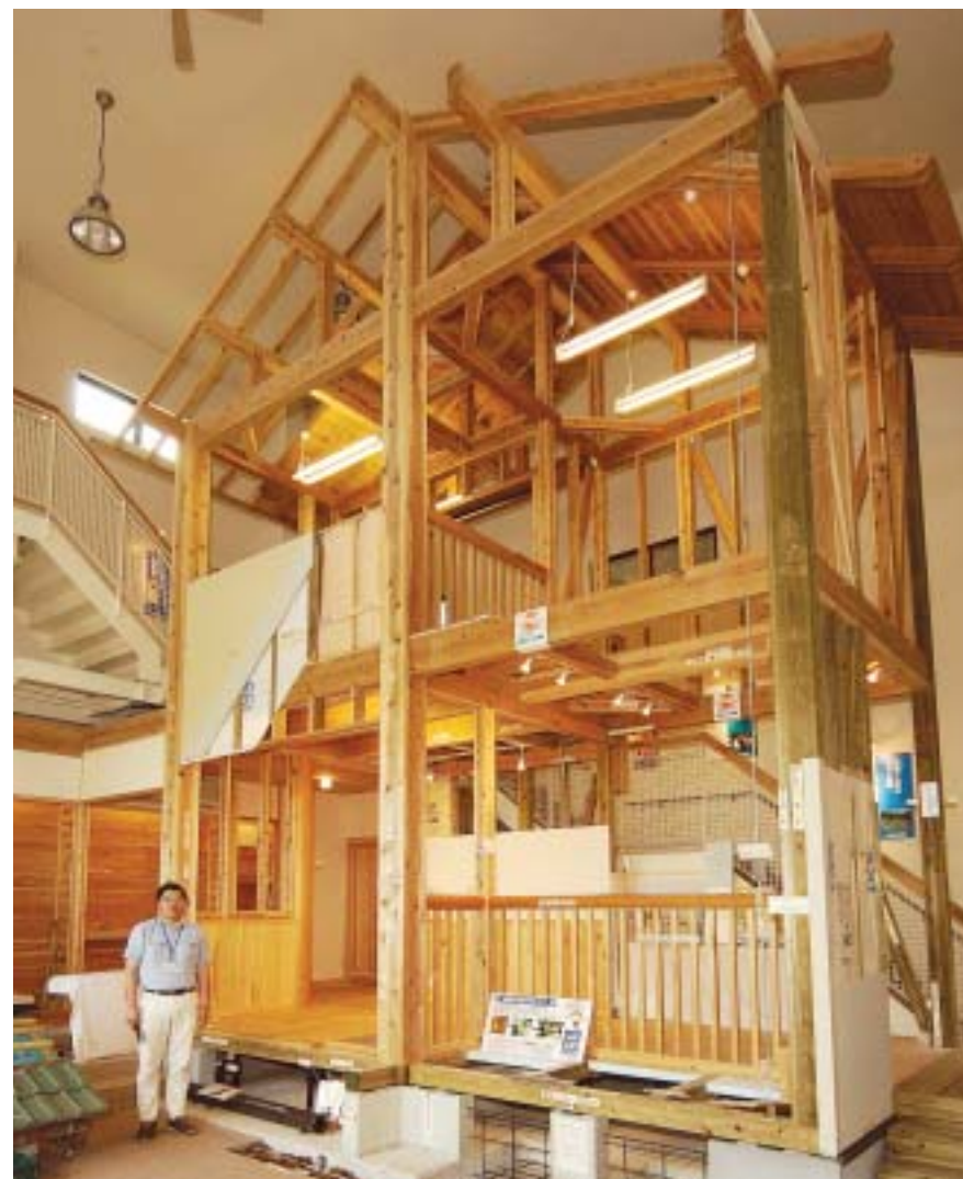
「住拓館」の中には、現物大の家の構造があり、見えない家の中を見せている。
