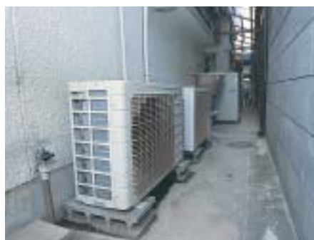
配管は床下を通しているため 室外機の設置場所は自在。
