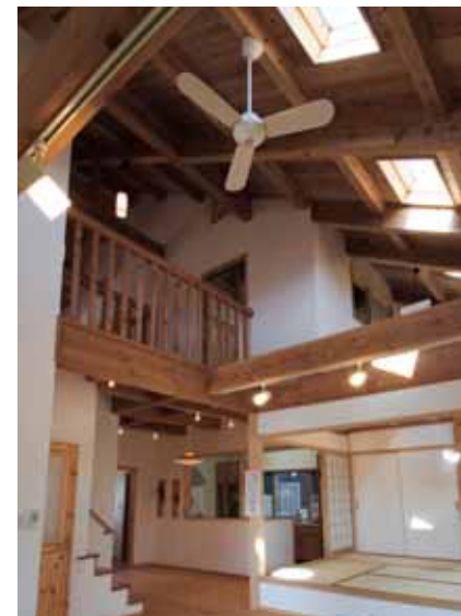
大きな梁と天然木で構成された吹抜け
